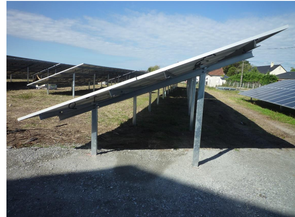
Illustration 24 : Exemple de pieux battus (Source : EREA Ingénierie)
