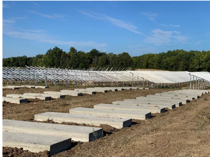
Illustration 26 : Photographie de fondations de longrines sur le site de Mer (41)
