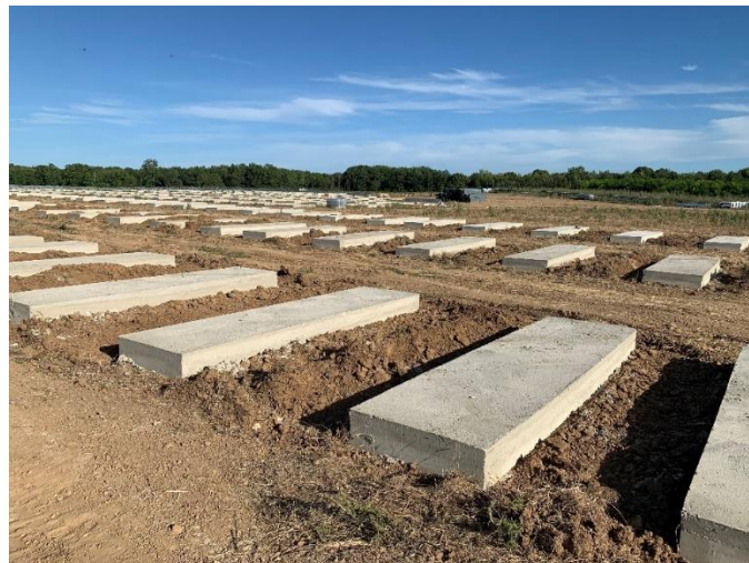
Illustration 33 : Longrines sur la centrale photovoltaïque de Mer (41) (Source : EREA Ingénierie)
