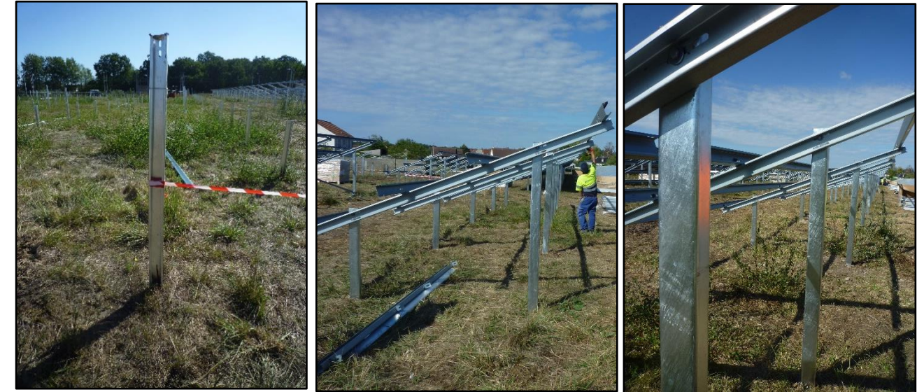
Illustration 34 : Montage des structures porteuses (Source : EREA Ingénierie)
