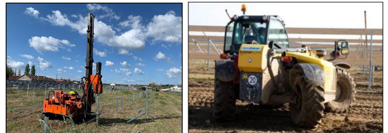
Illustration 32 : Exemple d'engins nécessaires sur le chantier : machine à sonnette de battage et manuscopique
